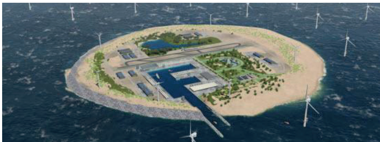
Illustration af den kunstige ø der kobles sammen med omkringliggende havvindmølleparker, hvorfra energien kan samles og distribueres til Nordsølandene i form af el eller brint.
